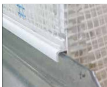
Detail aplikace připojovacího profilu parapetního
