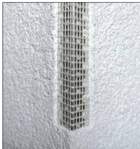
Detail umístění kombi lišty - řez
