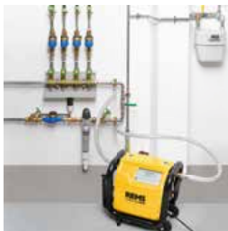
Proplachování rozvodů pitné vody
